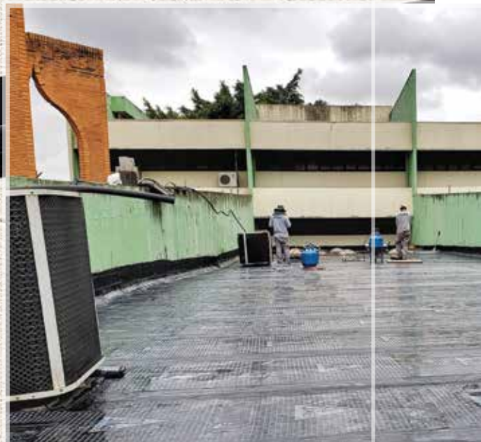
Obra de impermeabilização da cobertura do prédio
